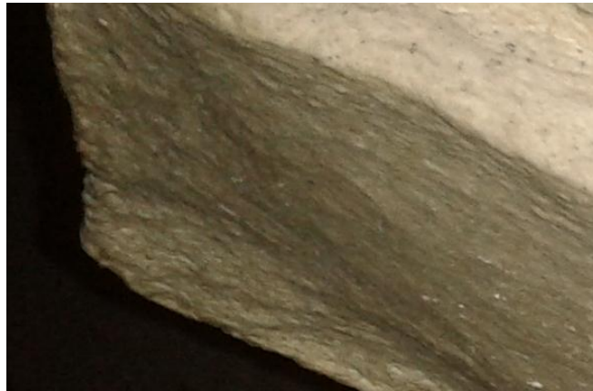
Figura 36. Vista de la porosidad que presenta el panel.
