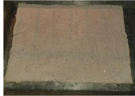
Figura 73. Panel con rupturas y deformación
